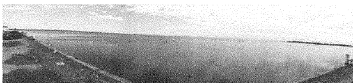
Panorámica del embalse del Embalse desde el dique frontal.
